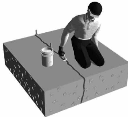
Figura 9 .Instalación de boquillas de inyección.
